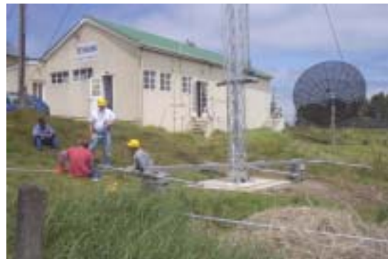
R.St.Helena アンテナ建設光景 (同局 HP より)
